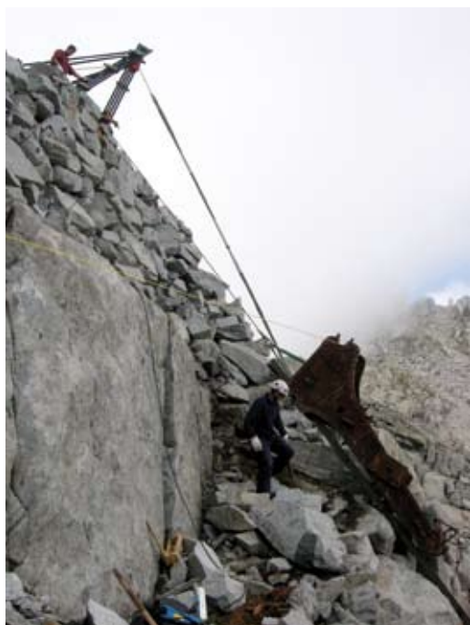
Un momento della fase di sistemazione - nelle consolidate piazzole originarie - di uno dei 4 affusti per cannone recuperati
