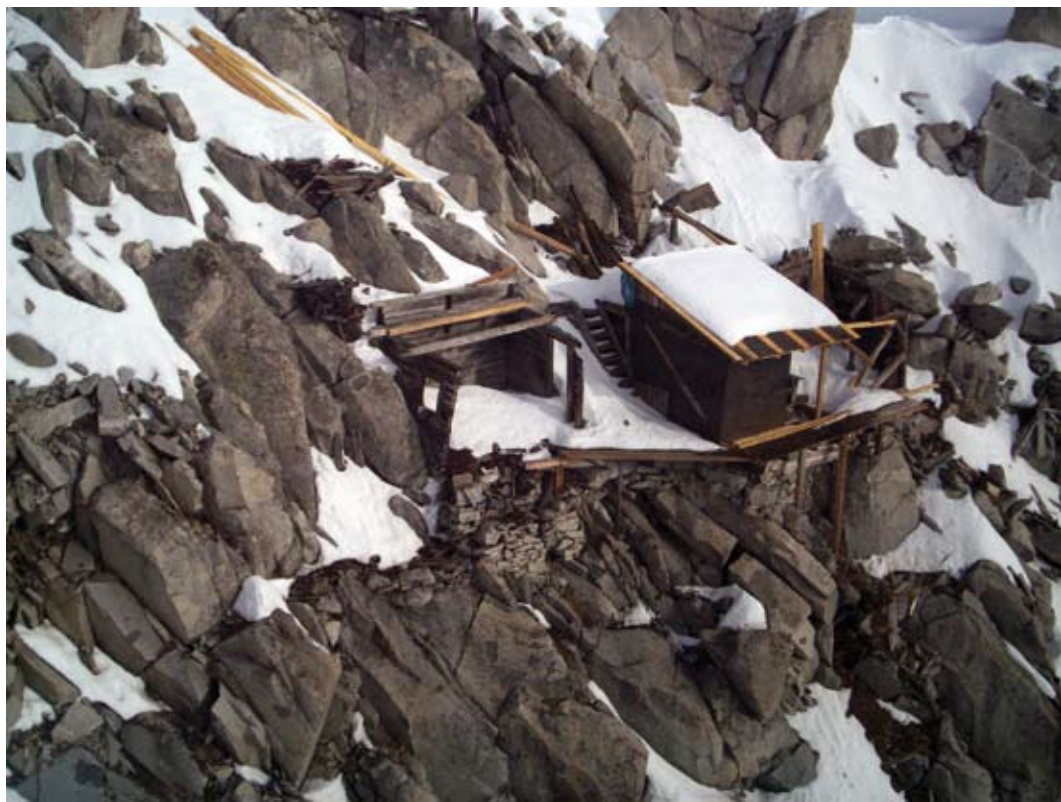
Lavori di restauro della baracchetta austroungarica in vetta al Carè Alto (quota 3.462 m)
