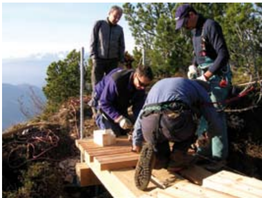
Messa a norma della ferrata G. Bertotti grazie al finanziamento della SAT centrale con alcune Guide alpine, Soci della Sezione e tecnici della Commissione Sentieri SAT
