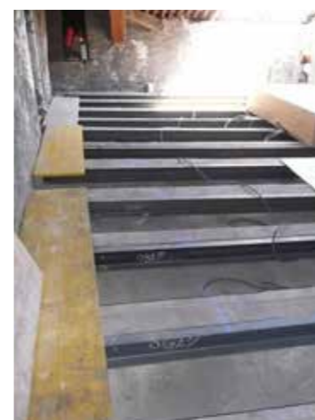
Consolidamento solaio del terzo piano (foto G.G.)
