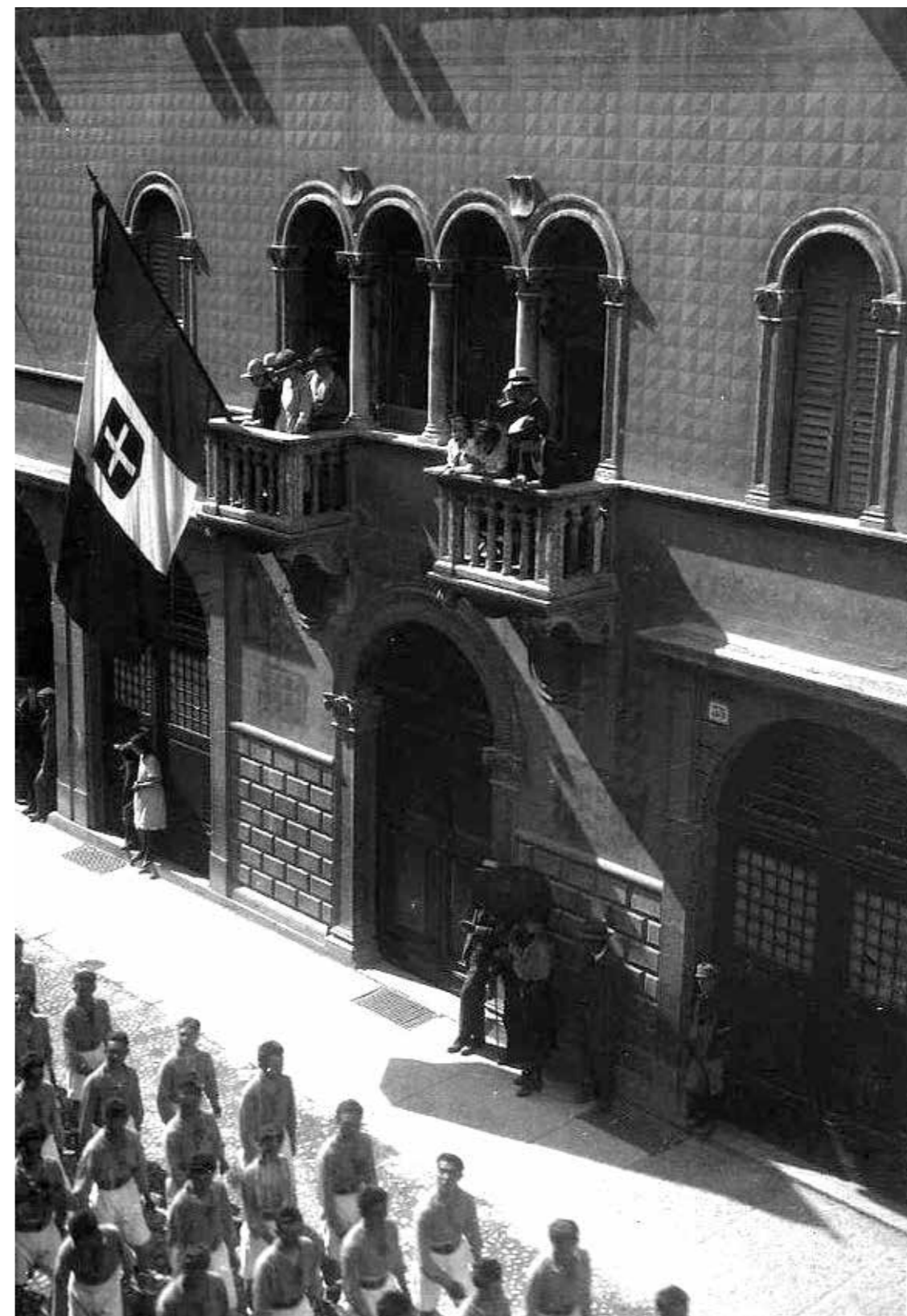
Alcuni componenti della famiglia Pedrotti assistono al passaggio dei concorrenti del Concorso ginnico del 1921 (PAT, sbc141576)
