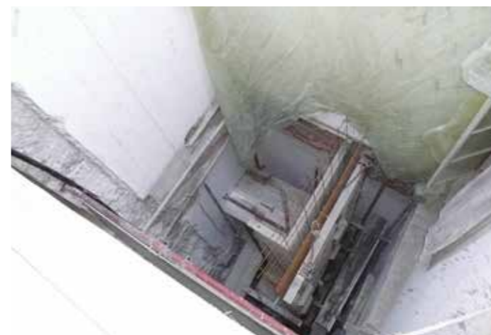
L'installazione dell'ascensore (foto G.G.)
