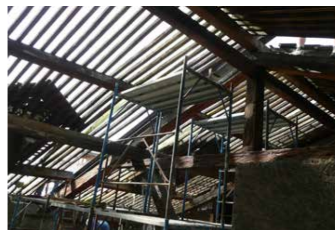
I lavori sul tetto (foto G.G.)
