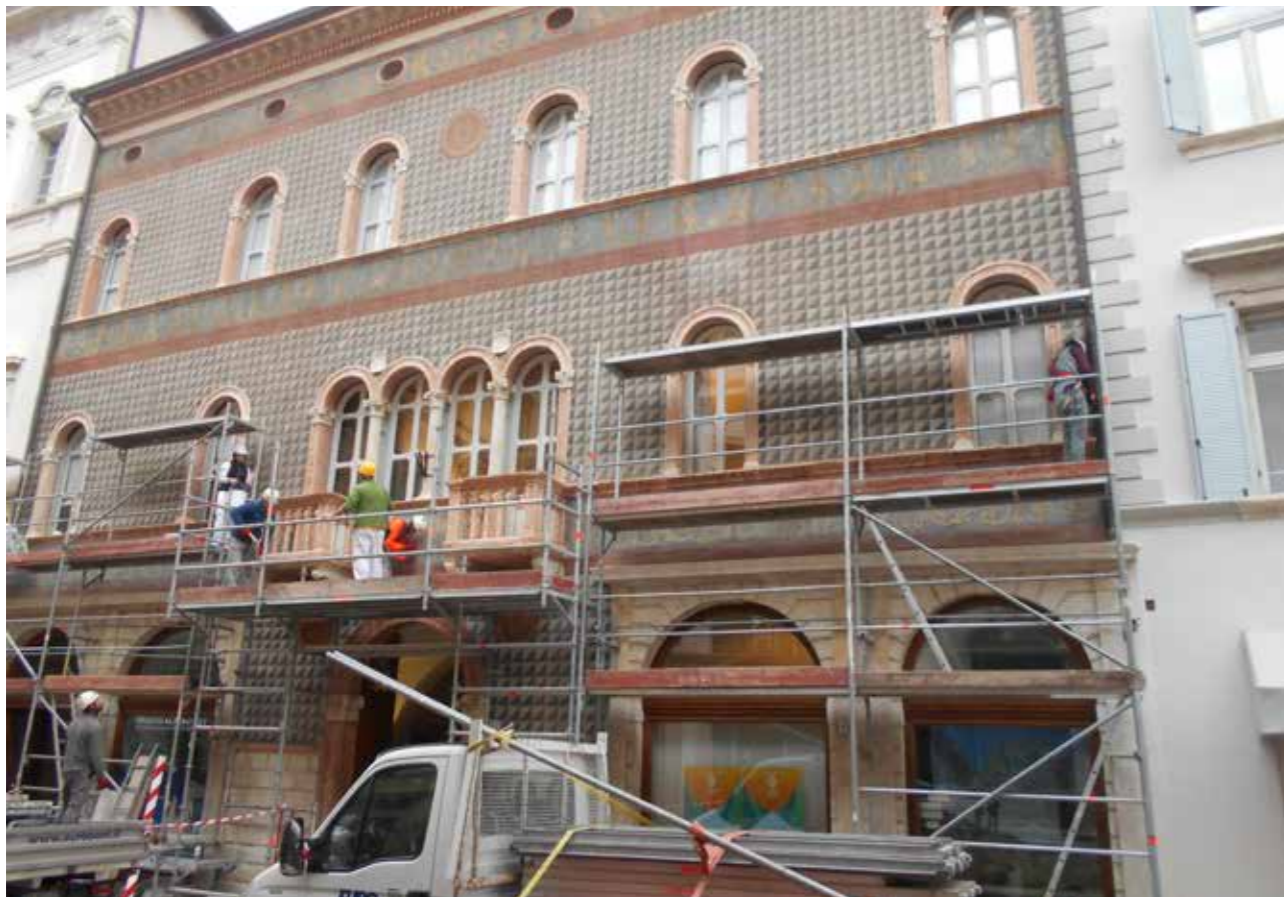
Il restauro della facciata nel 2019 (foto R.D.)
