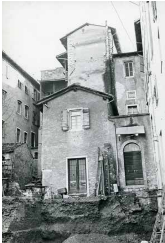
Vicolo dell'Adige, lavori di rimozione della vecchia costruzione; nel corso degli scavi emersero alcuni reperti archeologici di epoca romana, foto Fratelli Pedrotti, 1960 circa (AURS)
