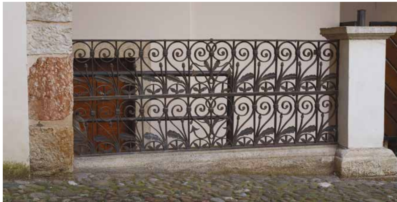
La balaustra in ferro battuto che separa i servizi e il locale caldaia dal resto del cavedio (foto M.C.)
