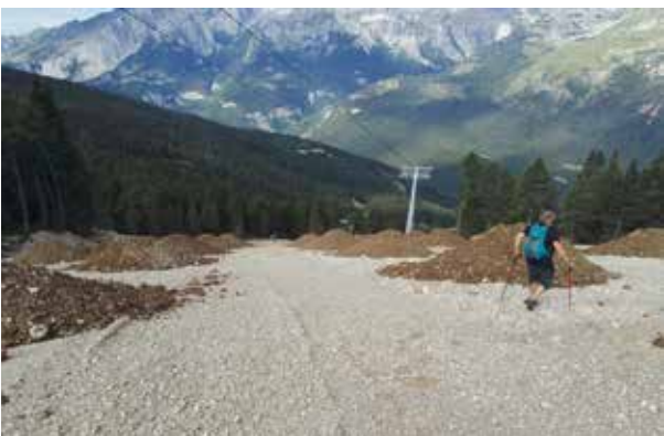
Movimenti terra lungo le piste da sci
